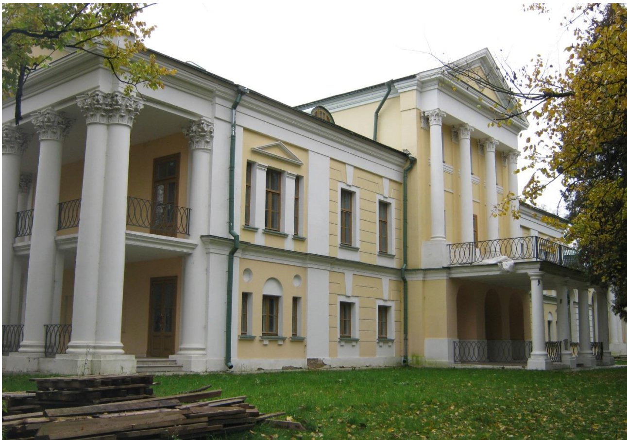
Главный дом, кон. XVIIIв. Вверху – северный фасад, внизу – южный фасад.
