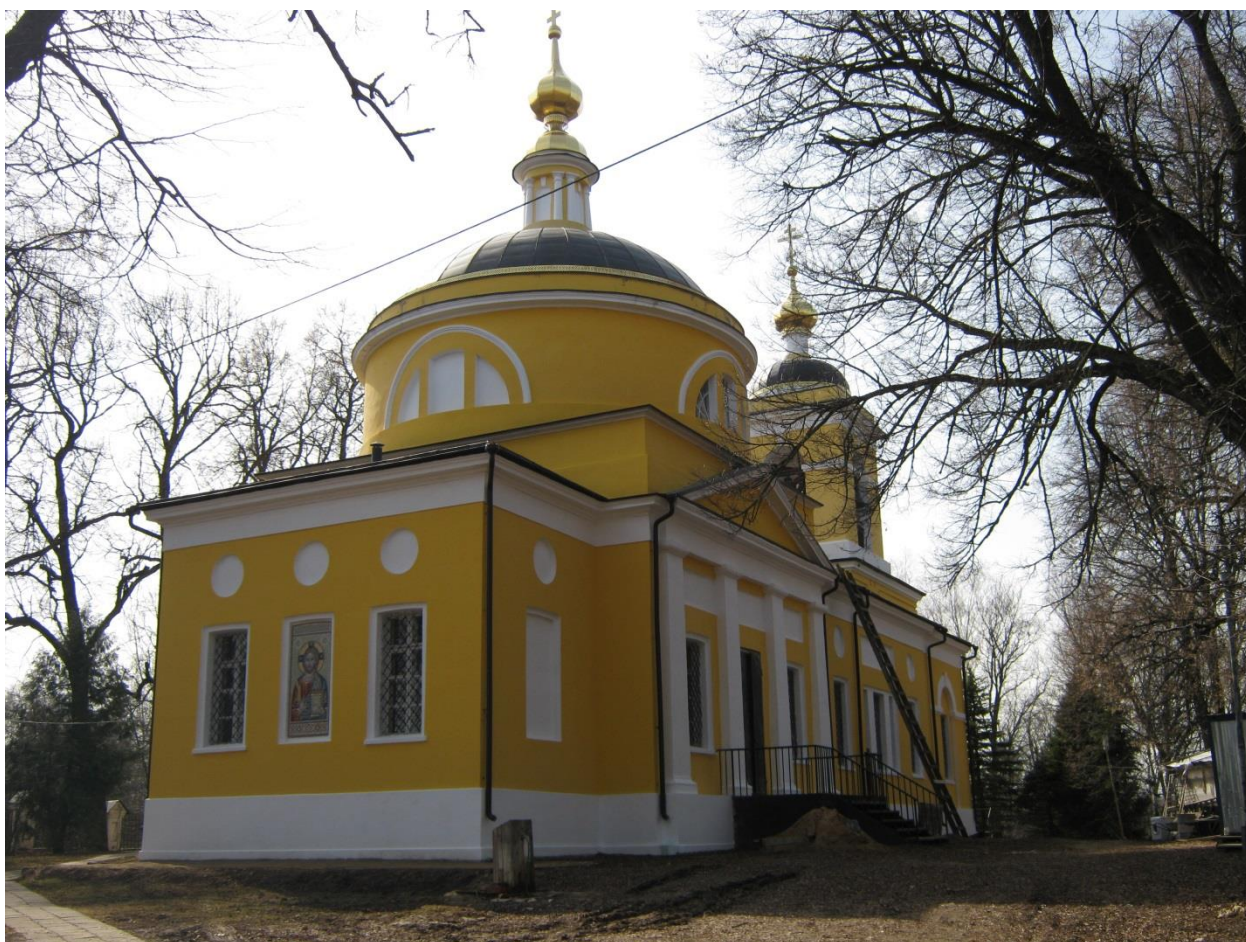
д. Рождествено. Вид на Церковь Рождества Христова с северо-востока.
