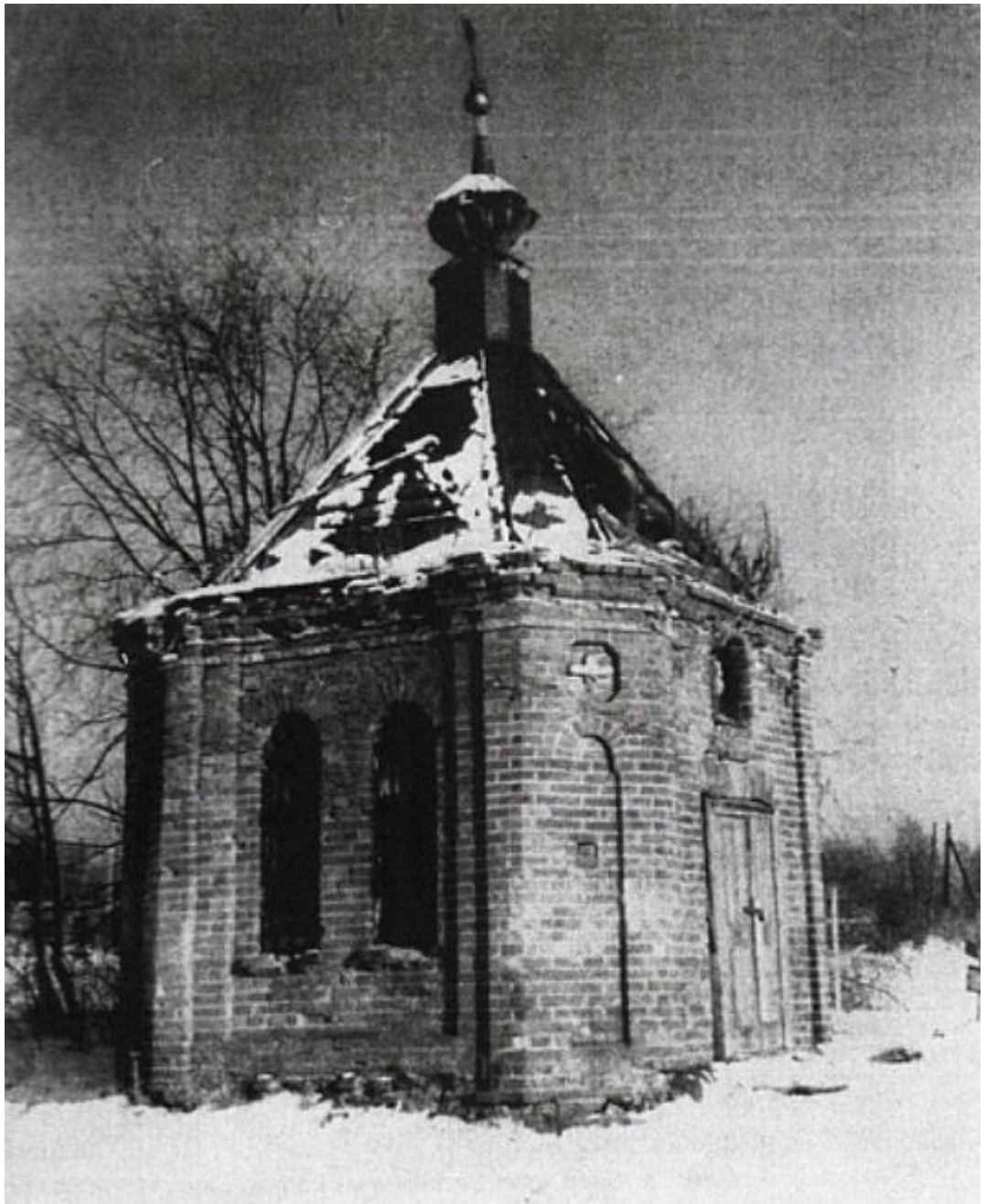
Вид часовни с северо-запада, до реставрации. Снимок 1980-хх.
